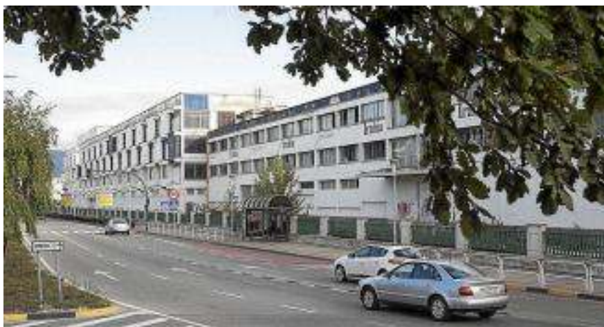
Antiguas instalaciones de Super Ser en Pamplona, antes de ser derribadas el año pasado. Foto: Patxi Cascante
